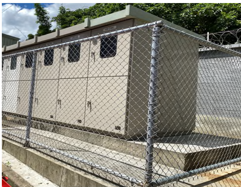
解說圖 909-1：帶電部分裝設於上鎖之封閉箱體
