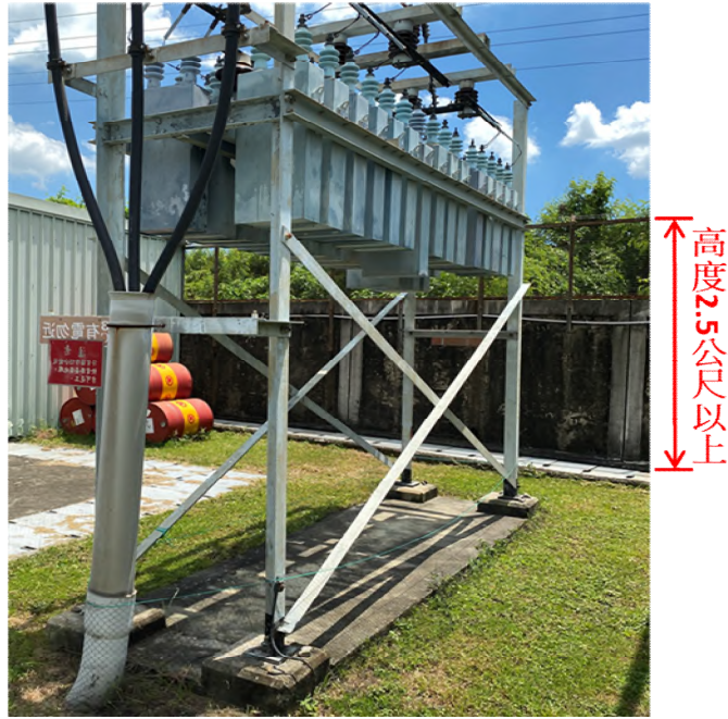
解說圖 909-2：開放式裝置設置圍牆或圍籬
