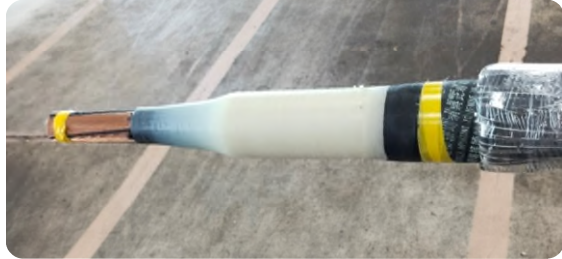
去除外部半導體層露出絕緣體 再去除部分內部半導體露出導體
