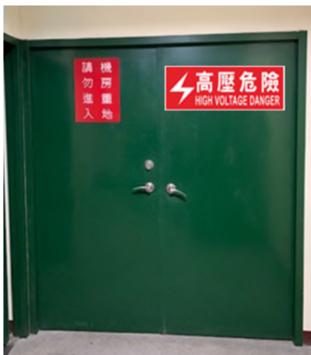
解說圖 949-1：變電室警告標識示意圖（字樣依條文標示高電壓危險）
