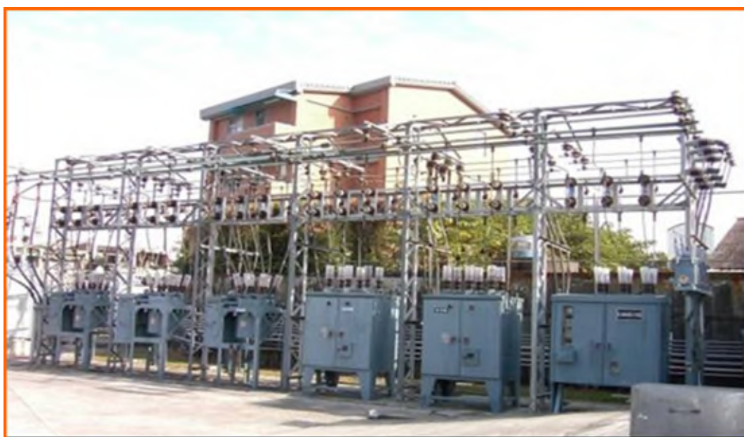
解說圖 921-1：變電所內架空裸匯流排
