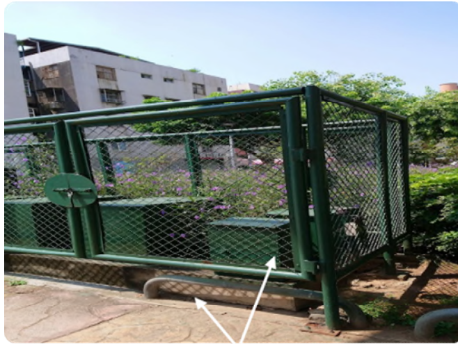
防護裝置 (圍籬、車擋欄杆)
