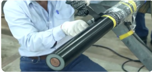
拉開遮蔽銅線露出外部半導體層
