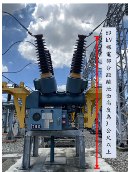
解說圖 948-4：69 kV 匯流排距離地面高度
