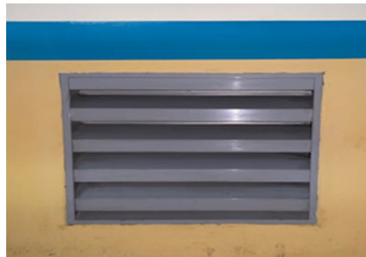
解說圖 946：變電室通風口防火閘板範例
